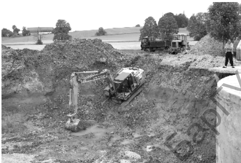
Рисунок 5.3 — Рытье котлована под строительство биостанции [82]
