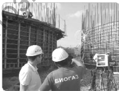
Рисунок 2.69 — Строительство биостанции фирмой Zorg Biogas AG [83]
