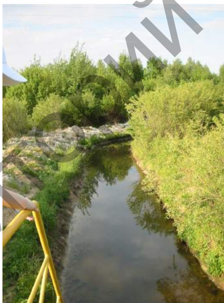
Рис.4 – Водосбросный канал. Завод «Атлант». Окрестности г.Барановичи
