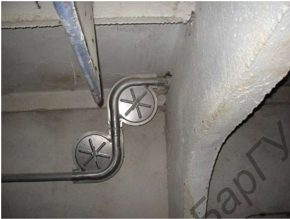
Рисунок 9 – Вид на поворотные устройства линии раздачи корма
