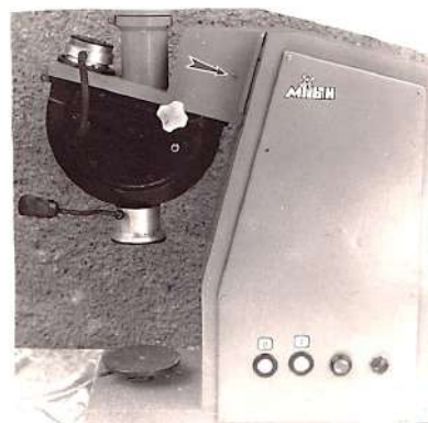
Рисунок 2 — Общий вид пружинной мельницы
