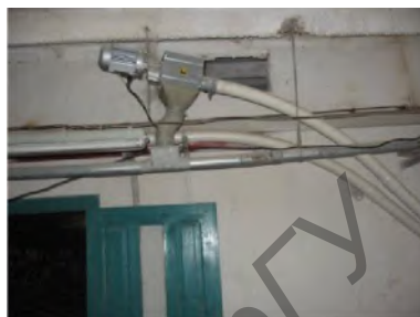
Рисунок 50 – Привод кормовых труб и кормовые трубы линии поперечной раздачи
