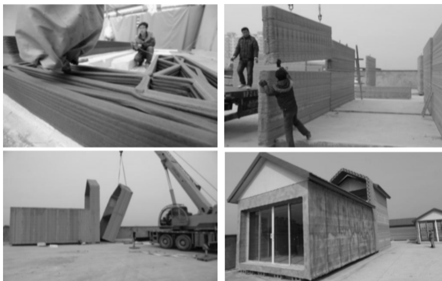
Рисунок 3 — Дома, собранные из напечатанных блоков [1]
