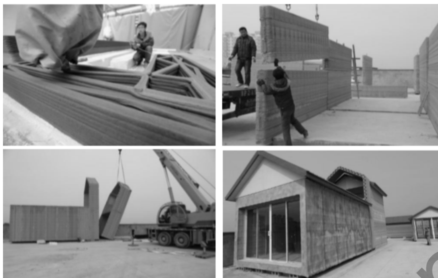
Рисунок 3 — Дома, собранные из напечатанных блоков [1]
